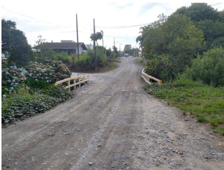
Foto 02: Ponte Rua Pedro Teixeira.
