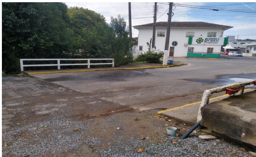
Foto 01: Ponte Rua João Raitz.
