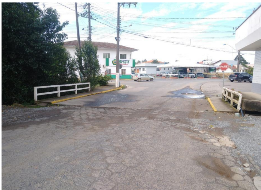
Foto 02: Ponte Rua João Raitz.
