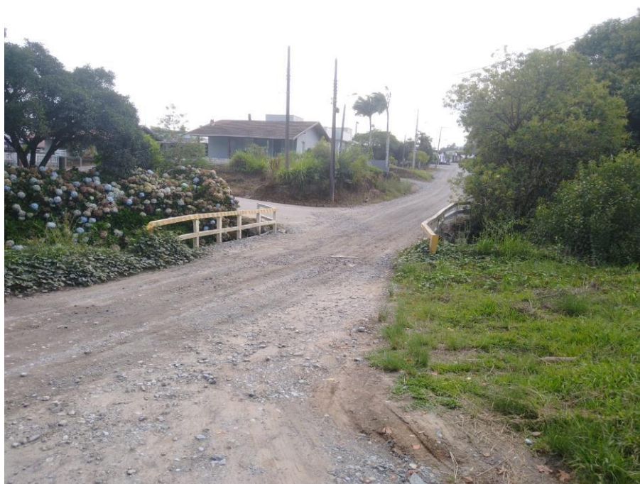
Foto 01: Ponte Rua Pedro Teixeira.
