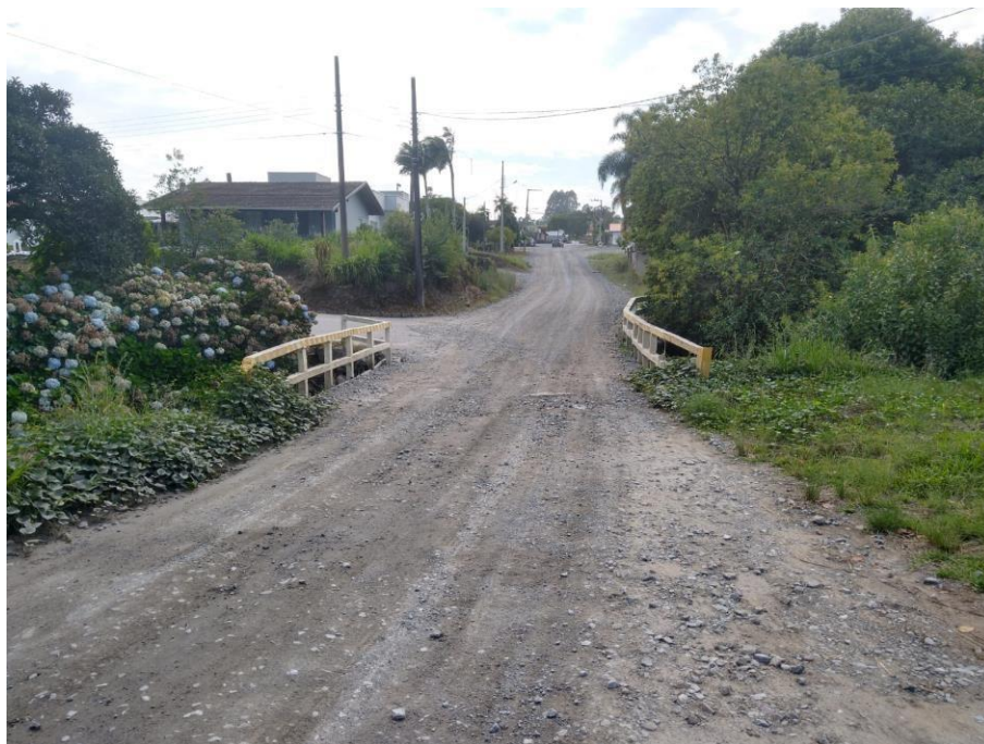
Foto 02: Ponte Rua Pedro Teixeira.
