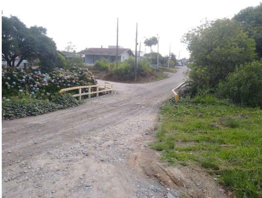
Foto 01: Ponte Rua Pedro Teixeira.
