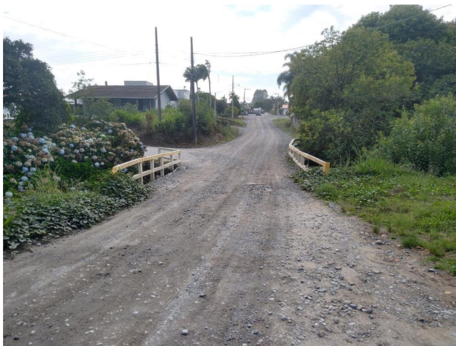
Foto 02: Ponte Rua Pedro Teixeira.
