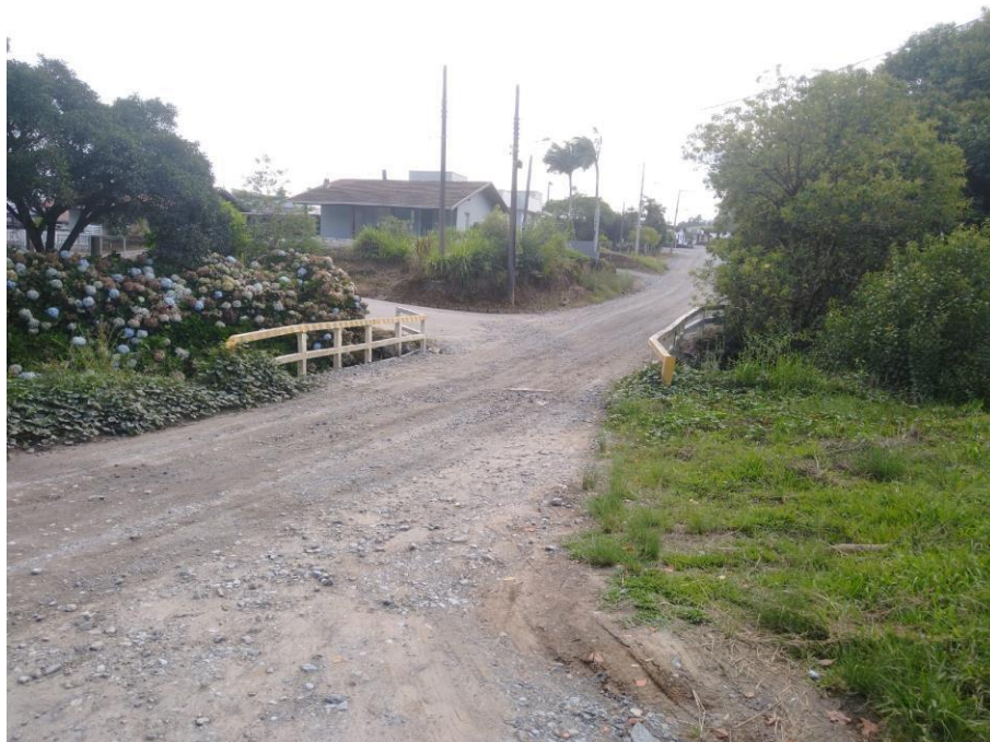
Foto 01: Ponte Rua Pedro Teixeira.
