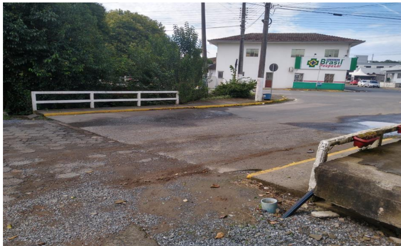
Foto 01: Ponte Rua João Raitz.
