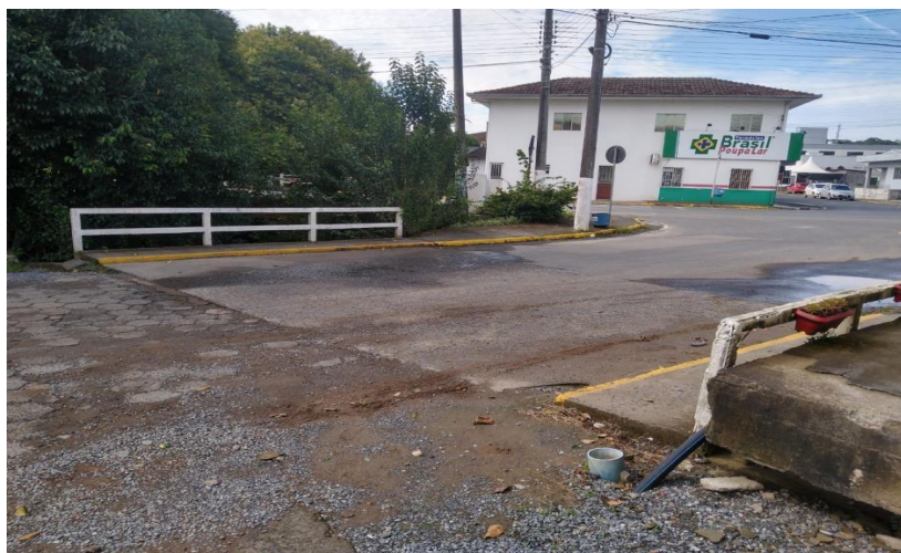
Foto 01: Ponte Rua João Raitz.
