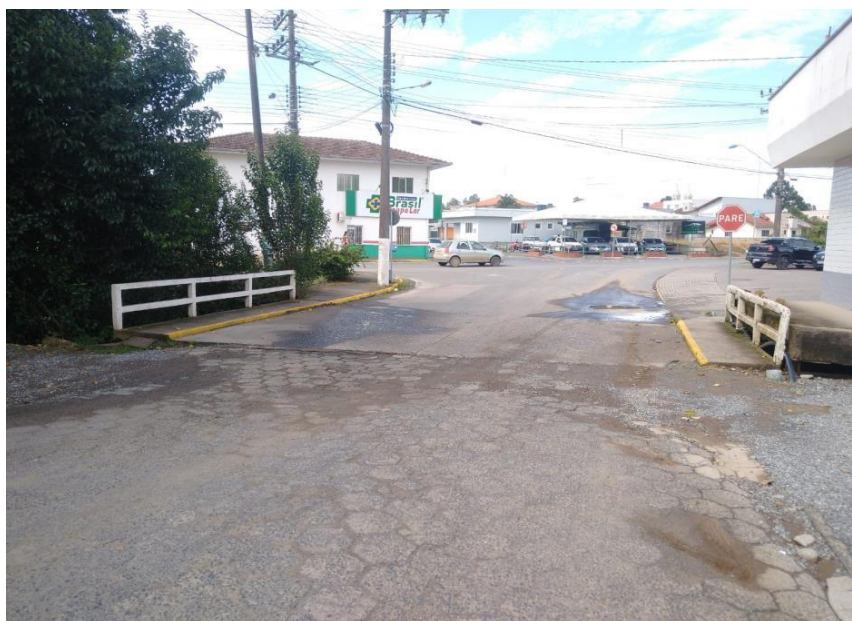
Foto 02: Ponte Rua João Raitz.
