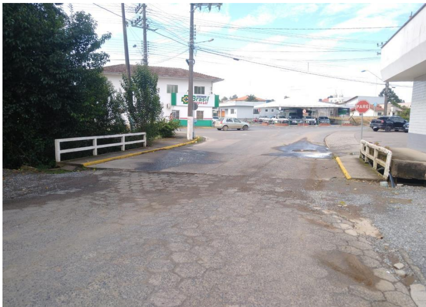
Foto 02: Ponte Rua João Raitz.
