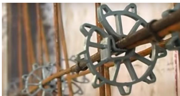
Imagem 03 – Armadura com espaçadores
