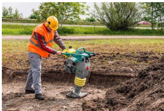
Imagem 05 – Execução de compactação de solo
