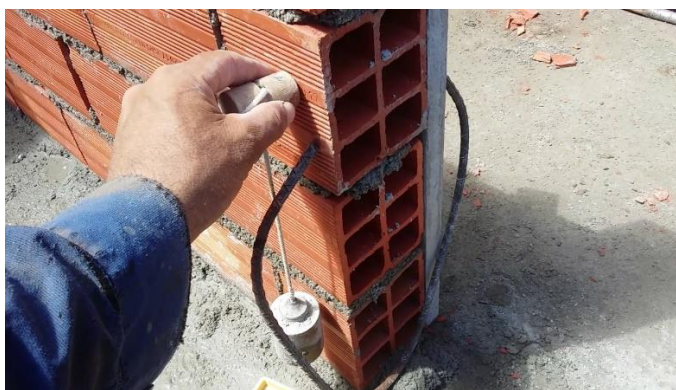
Imagem 06 – Conferência de prumo, início da execução
