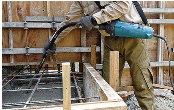
Imagem 04 – Utilização de vibrador de concreto para adensamento
