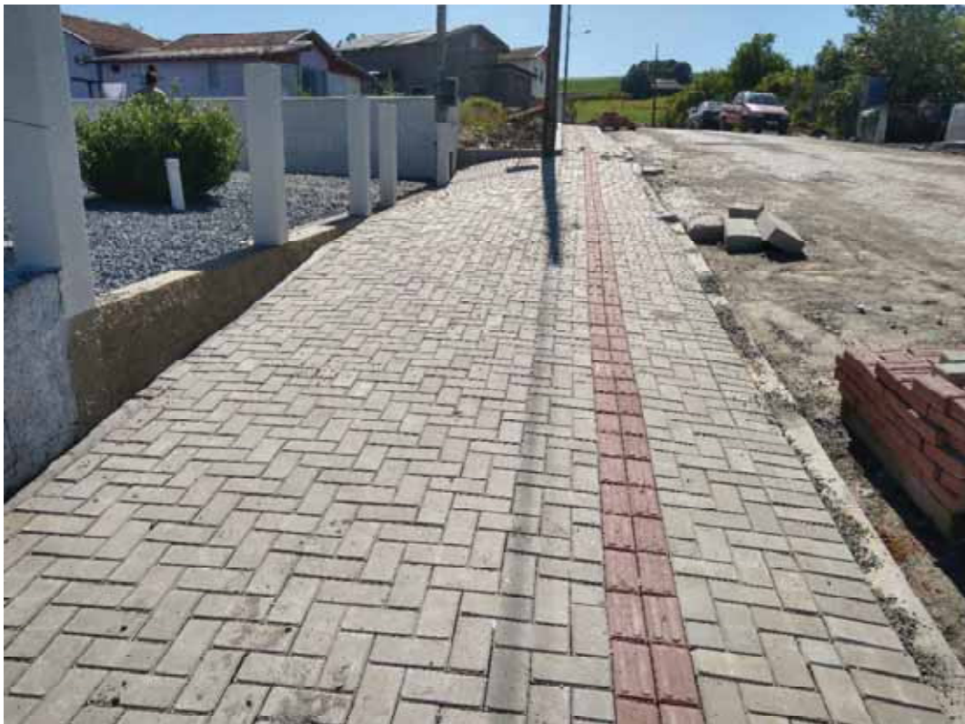
FOTO 06: Pavimentação Asfáltica Rua Nicolau Bernardo.
