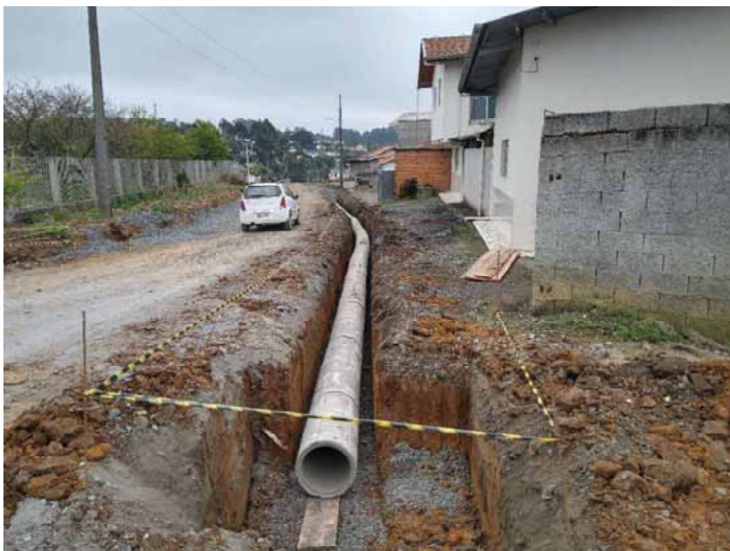
FOTO 04: Pavimentação Asfáltica Rua Nicolau Bernardo.
