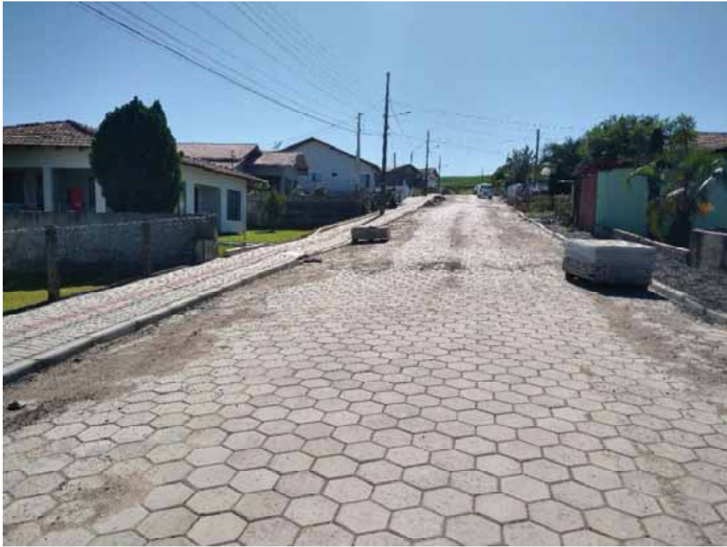
FOTO 05: Pavimentação Asfáltica Rua Nicolau Bernardo.
