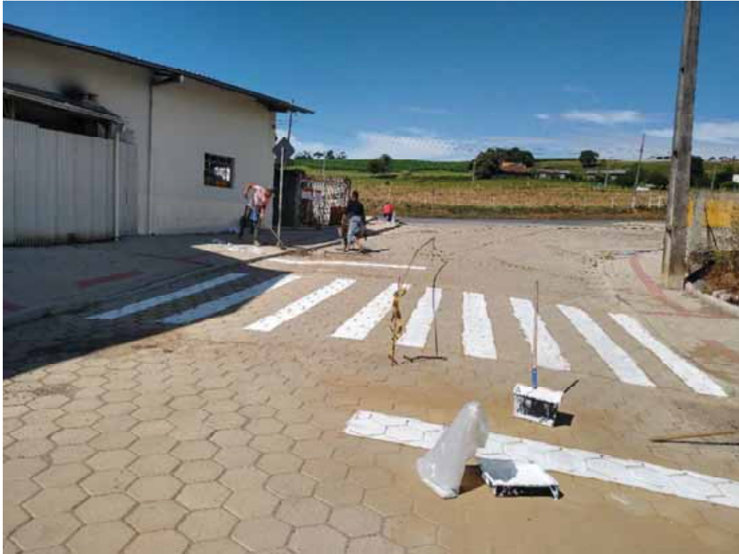
FOTO 07: Pavimentação Asfáltica Rua Nicolau Bernardo.
