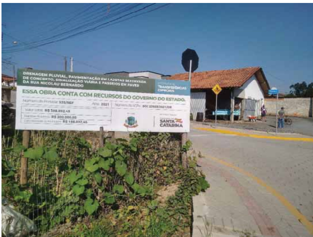
FOTO 10: Placa da Obra e Pavimentação Asfáltica Rua Nicolau Bernardo.
