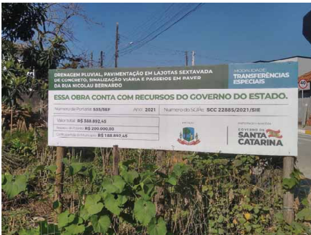
FOTO 09: Placa a Obra e Pavimentação Asfáltica Rua Nicolau Bernardo.
