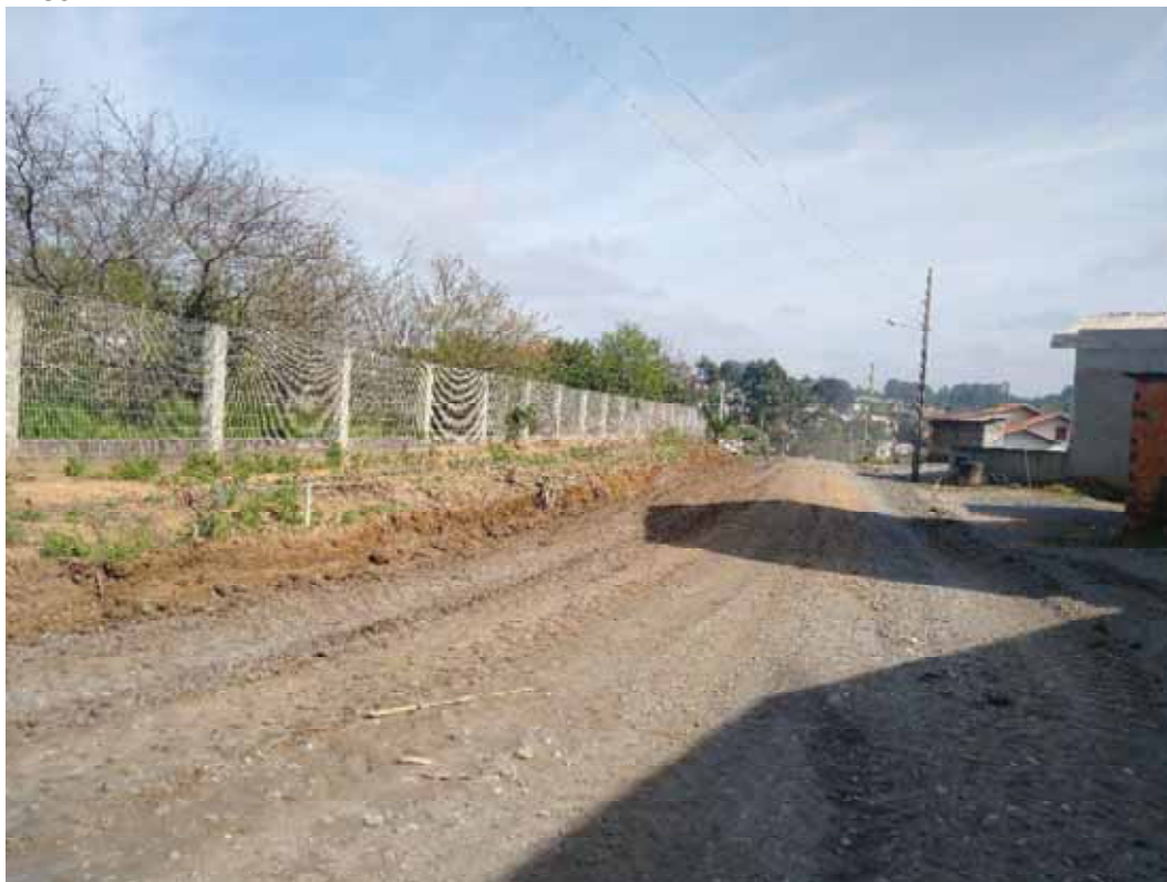
FOTO 01: Pavimentação Asfáltica Rua Nicolau Bernardo.
