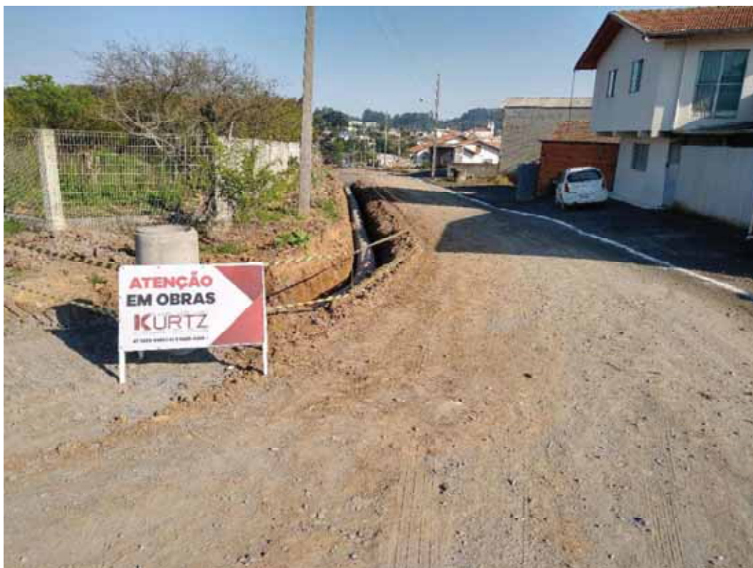
FOTO 02: Pavimentação Asfáltica Rua Nicolau Bernardo.
