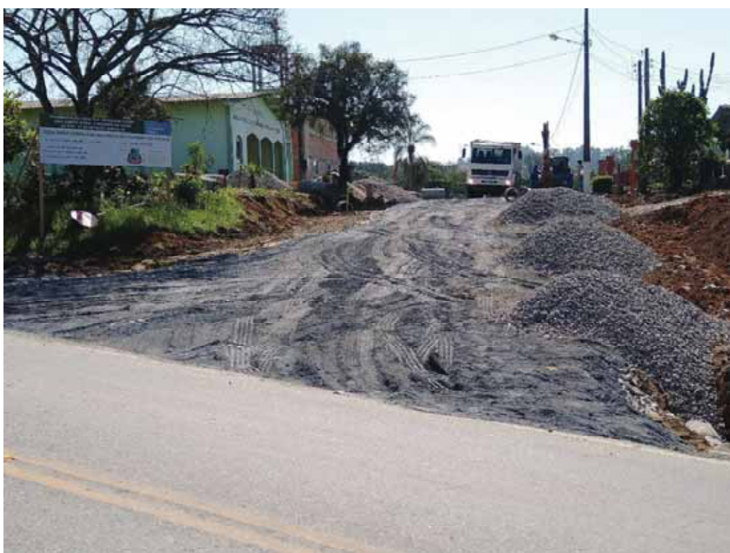
FOTO 06: Pavimentação Asfáltica Rua 31 de Outubro.
