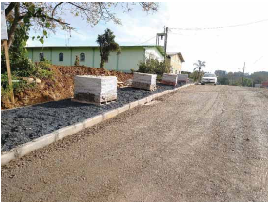
FOTO 08: Pavimentação Asfáltica Rua 31 de Outubro.
