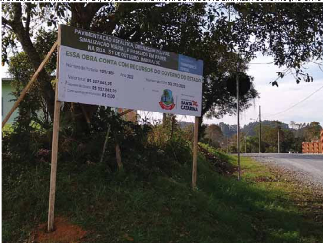
FOTO 01: Placa da Obra Pavimentação Asfáltica Rua 31 de Outubro.
