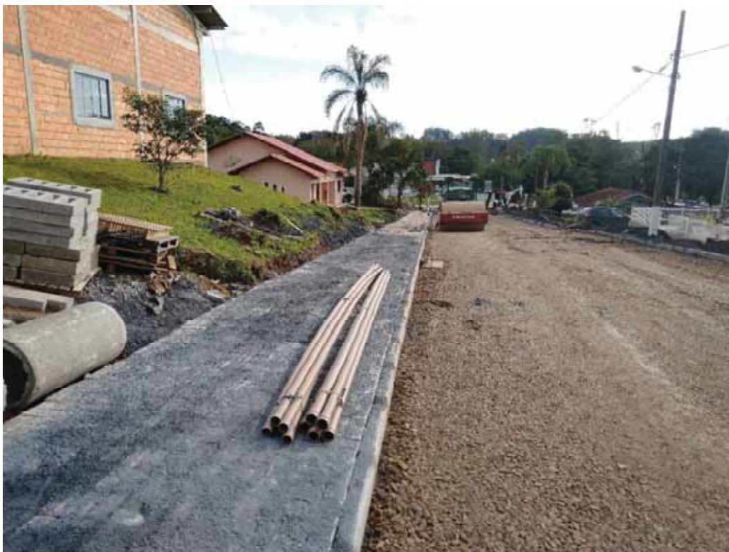
FOTO 09: Pavimentação Asfáltica Rua 31 de Outubro.
