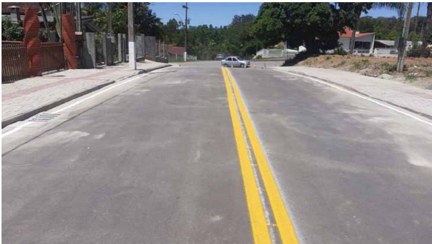
FOTO 11: Pavimentação Asfáltica Rua 31 de Outubro.
