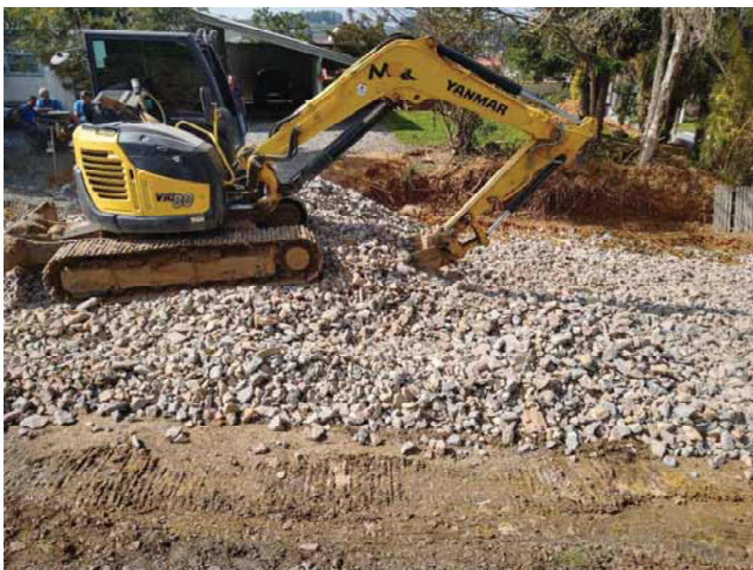
FOTO 04: Pavimentação Asfáltica Rua 31 de Outubro.
