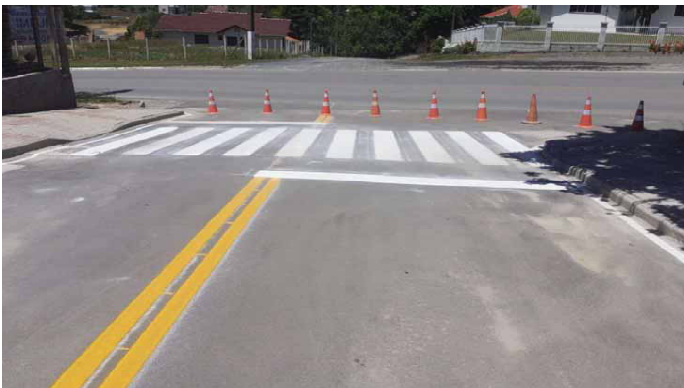
FOTO 12: Pavimentação Asfáltica Rua 31 de Outubro
