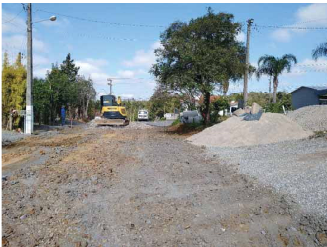
FOTO 03: Pavimentação Asfáltica Rua 31 de Outubro.
