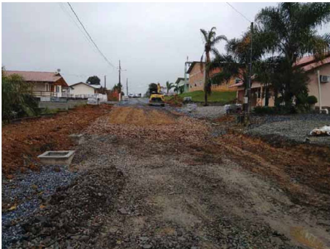
FOTO 07: Pavimentação Asfáltica Rua 31 de Outubro.
