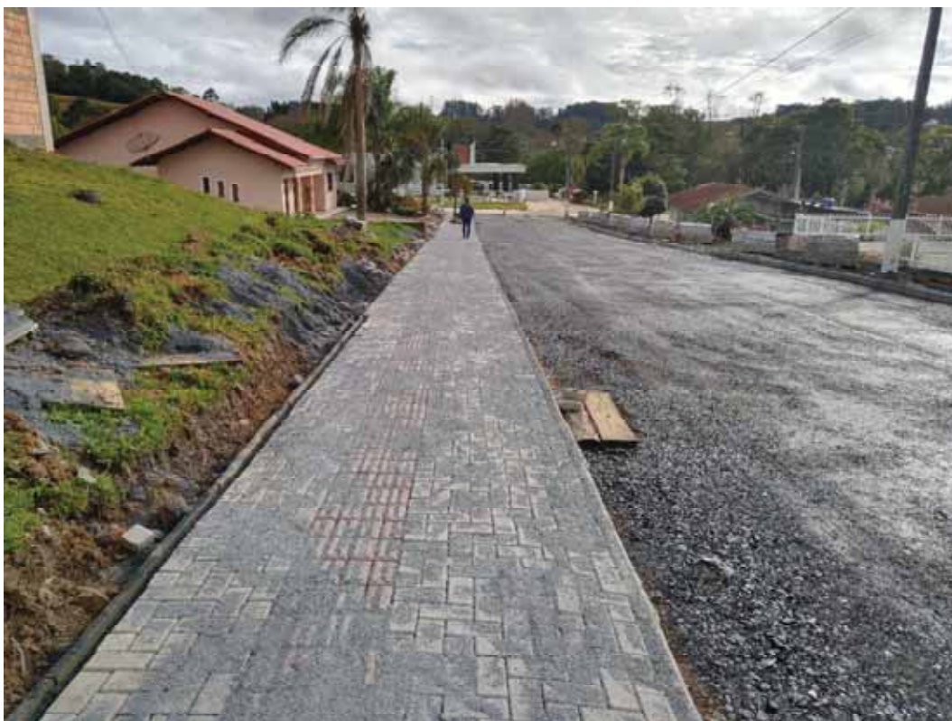
FOTO 10: Pavimentação Asfáltica Rua 31 de Outubro.
