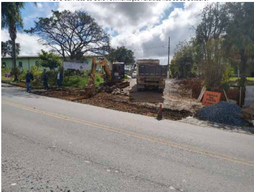
FOTO 02: Pavimentação Asfáltica Rua 31 de Outubro.
