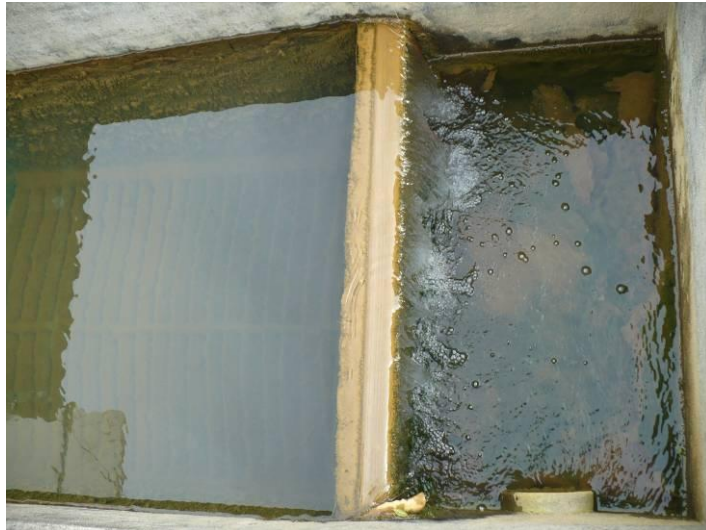
Figura 13: Decantador de alta taxa – com placas inclinadas. Fonte: Visita Técnica STE.
