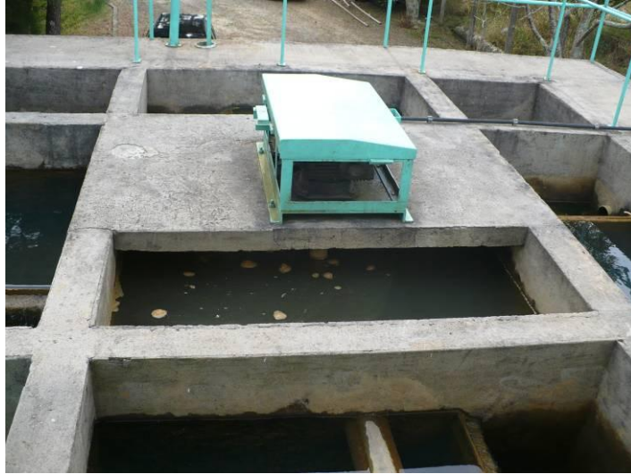
Figura 12: Floculador mecânico. Fonte: Visita Técnica STE.
