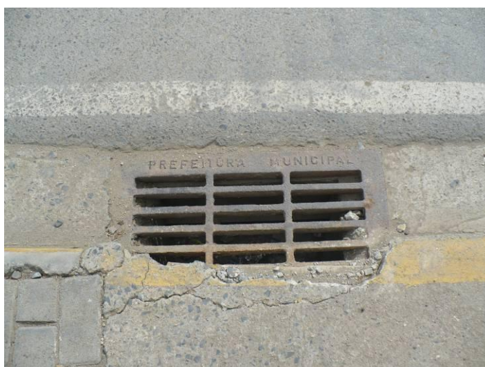
Figura 54: Boca de Lobo tipo grelha Fonte: Visita Técnica STE.
