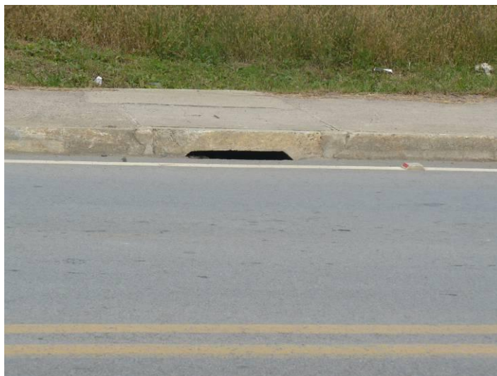
Figura 53: Boca de Lobo tipo Guia Fonte: Visita Técnica STE.
