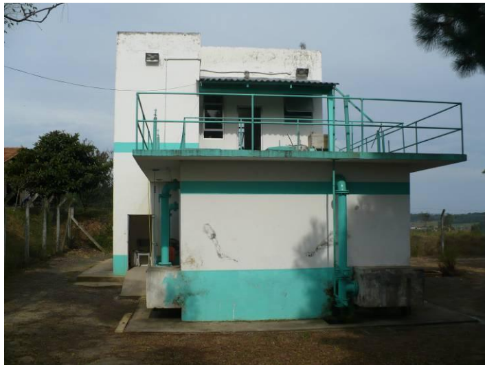
Figura 9: ETA – Estação de Tratamento de Água. Fonte: Visita Técnica STE.
