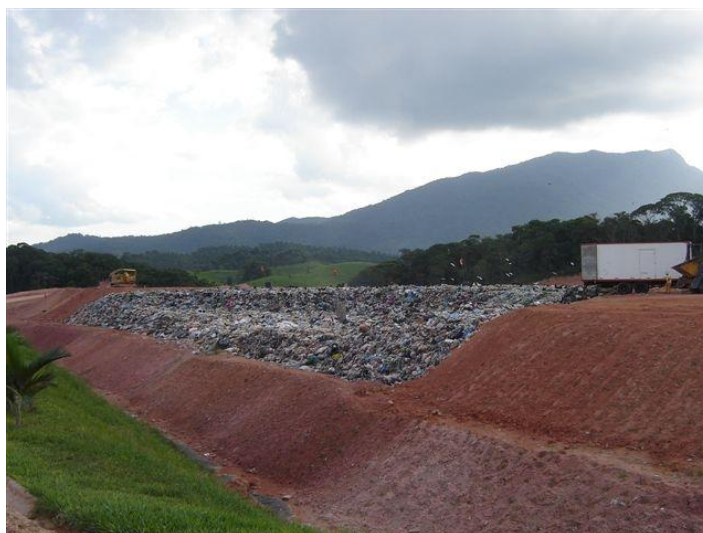
Figura 48: Vista geral do Aterro Sanitário da empresa RECICLE em Brusque / SC. Fonte: RECICLE
