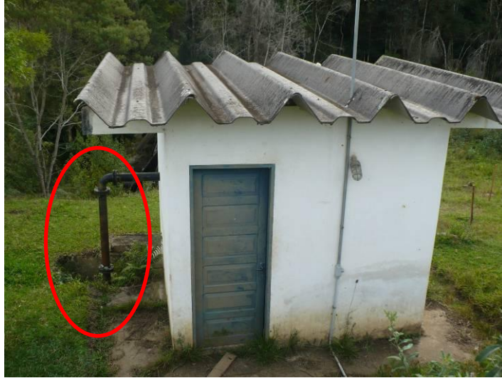
Figura 8: Adutora de água bruta. Fonte: Visita Técnica STE.
