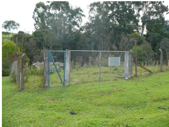
Figura 5: Portão de acesso a captação e estação elevatória de água bruta. Fonte: Visita Técnica STE.
