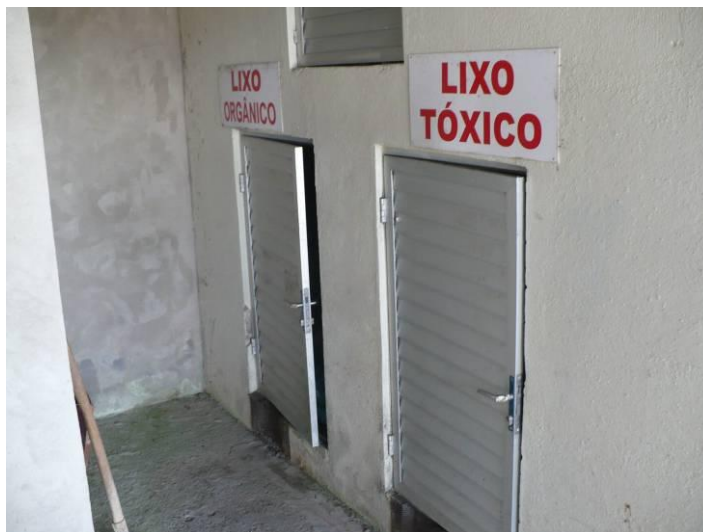
Figura 45: Armazenamento temporário dos resíduos de serviços de saúde. Fonte: Visita Técnica STE.
