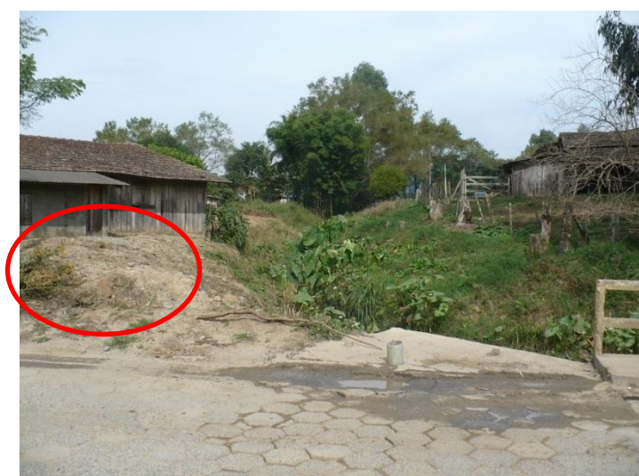
Figura 60: Material retirado de leito do arroio assoreado Fonte: Visita Técnica STE.
